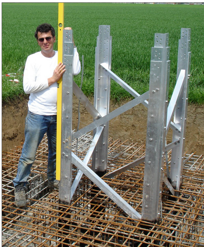
Kontrolle vor dem Betonieren - Grundriss des Mastes: 1m x 1m
