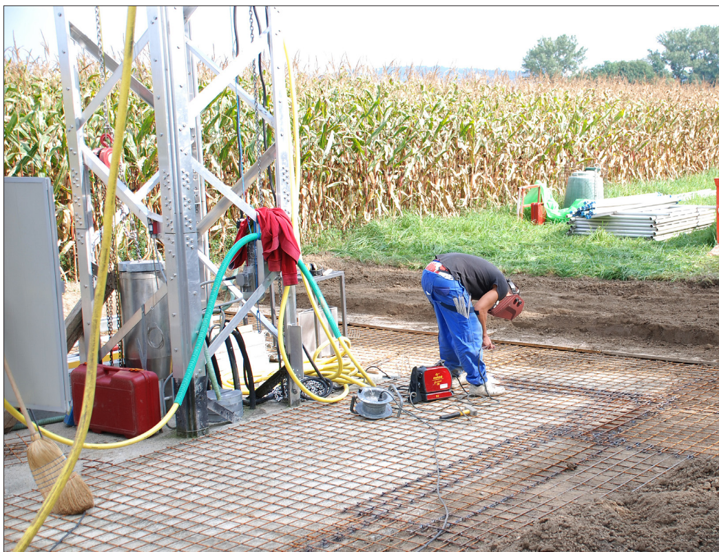
Réseau de terre en fer à béton
