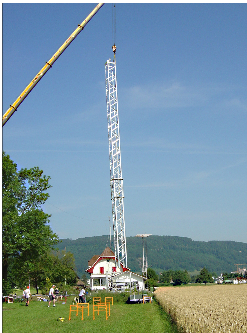
Montage du mât principal avec une grue de 50 mètres
